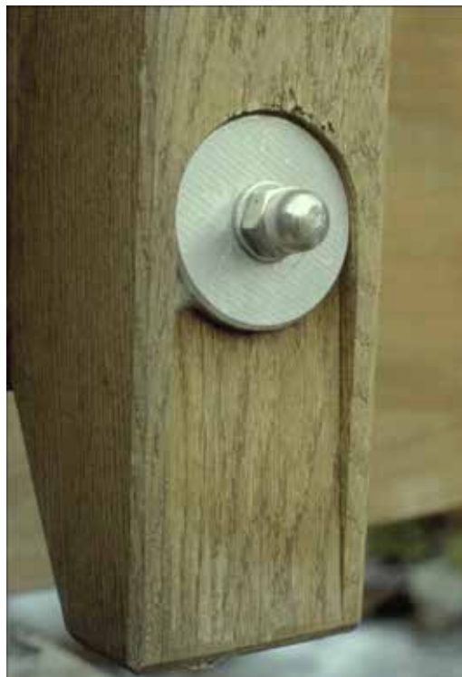
Abb. 6.1: Einlassen einer Unterlegscheibe an einem Pfostenanschluss eines Brückengeländers aus Eiche
