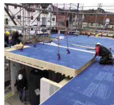
Abb. 4.2: Deckenelement mit selbstklebender, diffusionsfähiger Witterungsschutzbahn mit Überlappung
