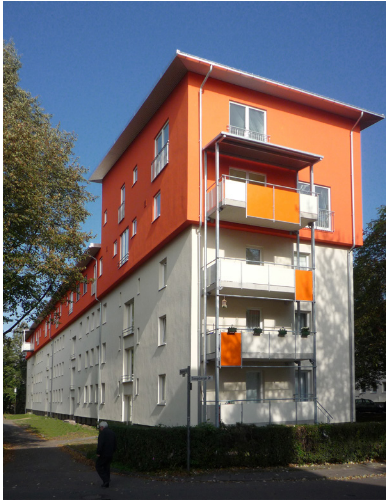
Abb. 2.29 – 2.33 Neben den deutlich erkennbaren Aufstockungen wurden die Gebäude aus den 1950er Jahren innen wie außen vollständig den heutigen Anforderungen angepasst.
