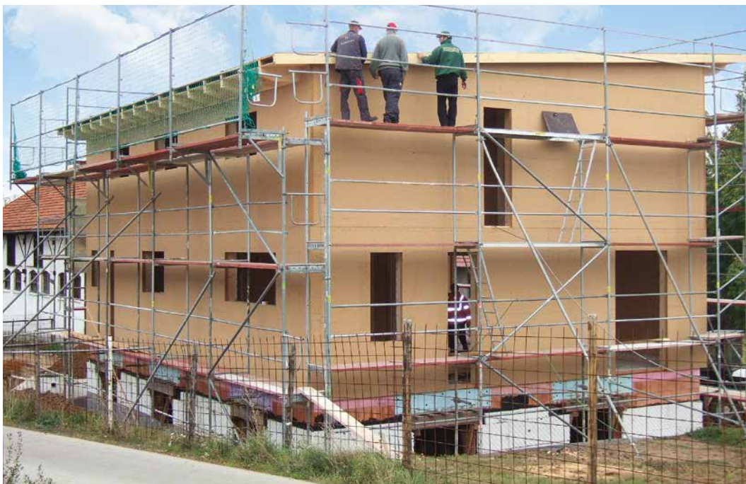
Abb. 10 und 11: Befestigung von Holzfaserdämmplatten auf Holzkonstruktionen
