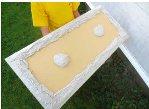
Abb. 13: Kleberauftrag im Punkt-Wulst-Verfahren
