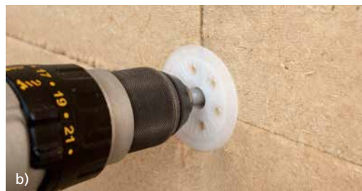
Abb. 14: Tellerdübel zur Befestigung von Holzfaser-WDVS auf mineralischen Untergründen: a) Tellerbefestiger b) Tellerbefestiger oberflächenbündig eingebaut
