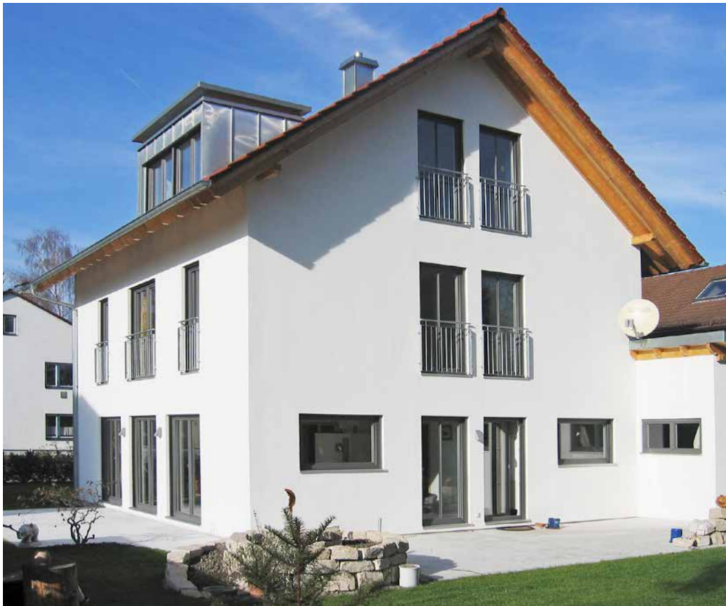
Abb. 1: Einfamilienhaus mit Holzfaser-WDVS
