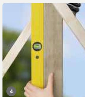
Mit einer Wasserwaage kontrollieren Sie, ob die Pfosten im Lot stehen. Korrekturen sind solange möglich, bis der Beton abbindet. Achten Sie daher auf die angegebenen Fixierzeiten auf der Verpackung. Entfernen Sie die Stützen und Hilfsmittel erst nach dem Aushärten des Betons. Erst jetzt können Sie mit dem Anschrauben der Zaunelemente beginnen.
