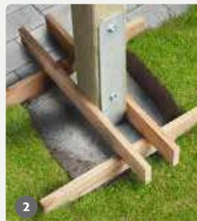
Als Montagehilfe mindestens 2 Latten am Pfostenende fest verschrauben. Legen Sie nun zwei Unterleghölzer unter, damit Sie Ihren gewünschten Abstand zwischen Erdboden und Pfosten erhalten. Setzen Sie den Pfosten inkl. Träger in das zuvor ausgehobene Fundamentloch (wir empfehlen eine Größe von 35 x 35 cm und 80 cm Tiefe).
